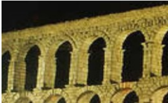
Arc plein cintre Aqueduc de Segovia, Espagne
