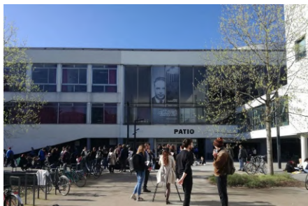
Bâtiment Le Patio
